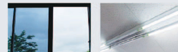
窓に熱遮断フィルムを貼り、エアコン負荷を軽減
